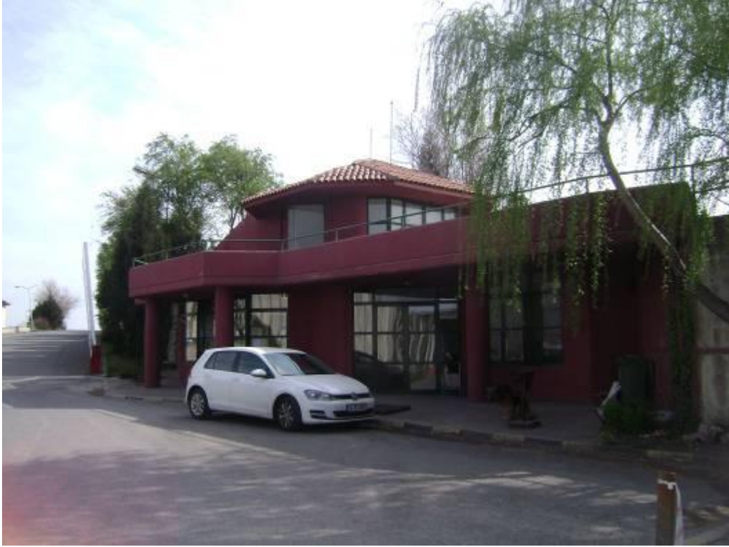
Güvenlik ve Personel giriş Binası
