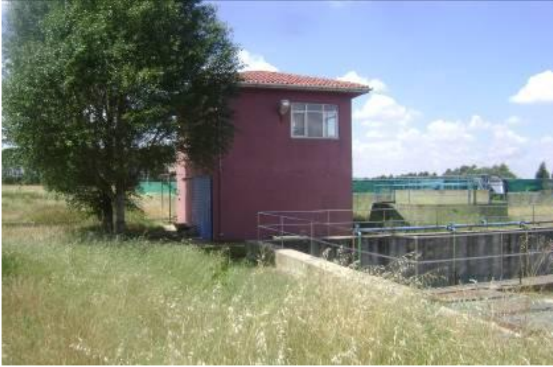
Arıtma Tesisi ve kontrol binası
